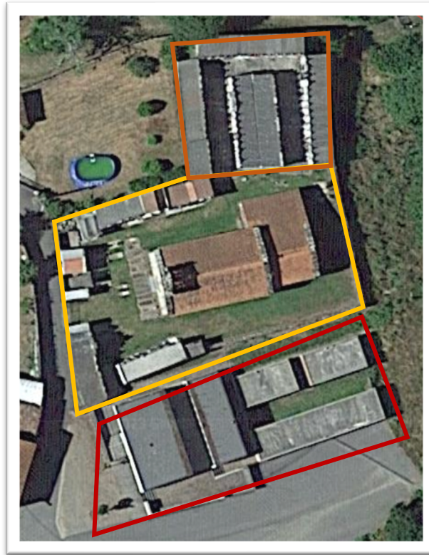
Figura 1. Cemiterio de Divino Salvador de Trasanqueros, Oza-Cesuras na actualidade. En amarelo sinalamos a área mais antiga, en laranxa a ampliación de finais dos anos setenta e en vermello, a ampliación de 2011-2013. Fonte: Google Earth
