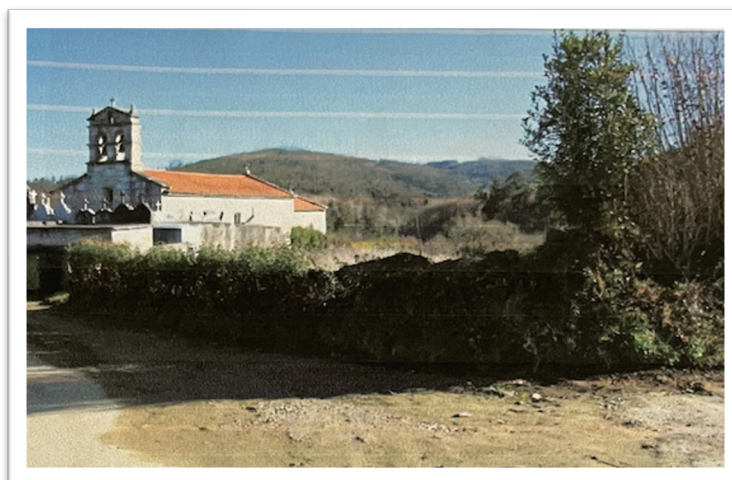
Figura 21. Vista xeral da Igrexa de Trasanqueros e arredores antes da ampliación do cemiterio de 2011-2013. Fonte: Expediente 40/2011, licenzas urbanísticas, concello de Cesuras.
