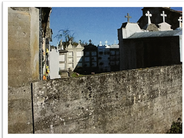
Figura 20. Muro lateral dereito de peche do cemiterio antes de que conectara coa ampliación de 2011-2013. Fonte: Expediente 40/2011, licenzas urbanísticas, concello de Cesuras.
