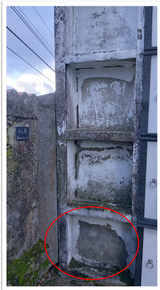
Figura 22. Detalle da construción de nichos onde se aprecia na parte inferior, a sepultura onde supostamente se atopan os restos da fosa (nº 148). Fonte: imaxe cedida pola ACMHD.
