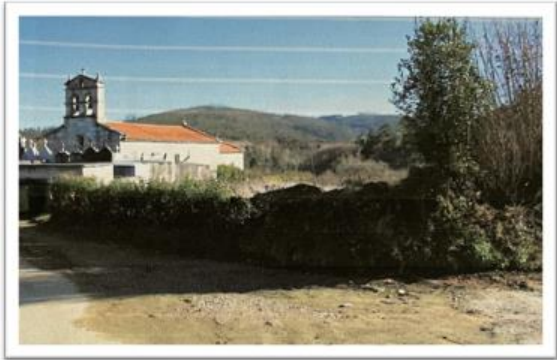
Figura 21. Vista xeral da Igrexa de Trasanqueros e arredores antes da ampliación do cemiterio de 2011- 2013. Fonte: Expediente 40/2011, licenzas urbanísticas, concello de Cesuras.
