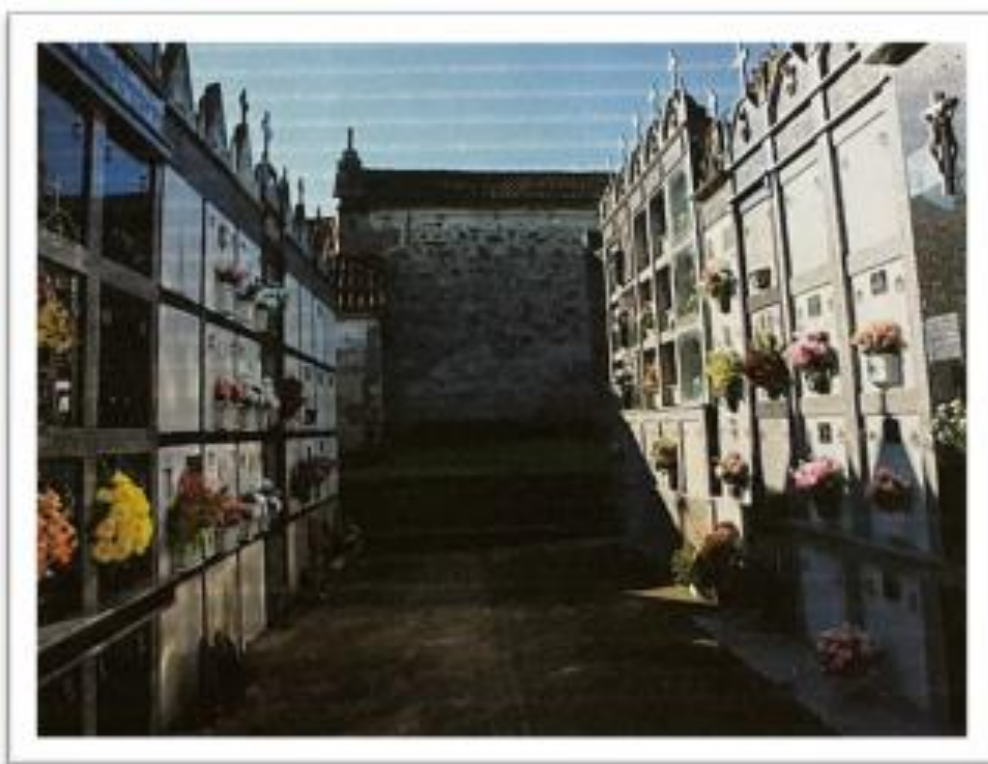
Figura 16. Vista da ampliación do cemiterio dos anos setenta. Fonte: Expediente 40/2011, licenzas urbanísticas, concello de Cesuras.
