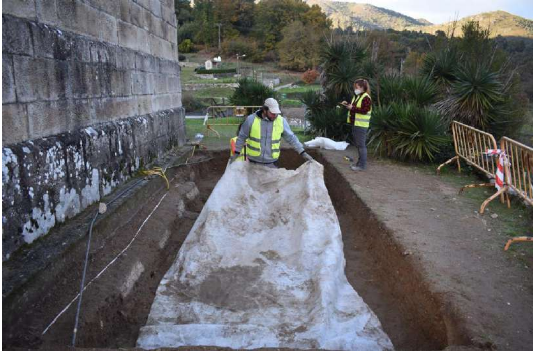
Imaxe 53: tapado con manta xeotextil
