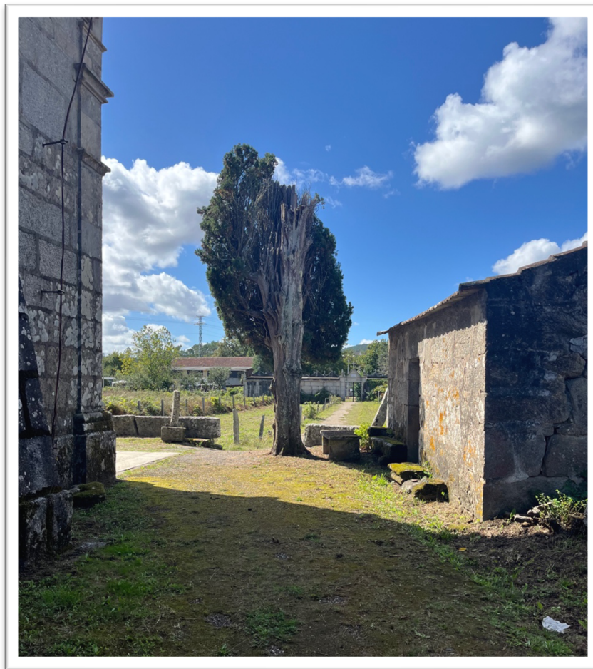
Figura 25. Vista do adro na que se aprecia o cable do pararraios na parede esquerda e a suposta zona da fosa, á marxe dereita, ao lado da caseta de autopsias. Fonte: fondo HISTAGRA.
