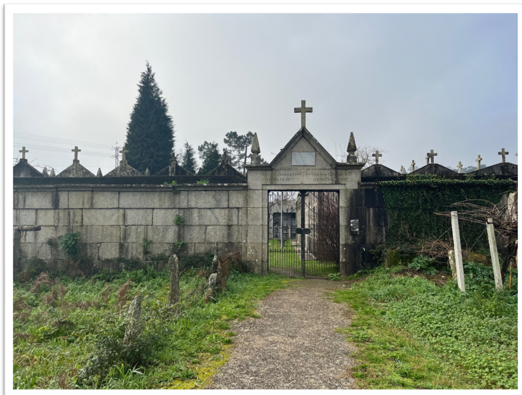
Figura 19. Acceso ao novo cemiterio onde se aprecia o camiño que enlaza co adro da Igrexa de San Miguel. Fonte: fondo HISTAGRA.
