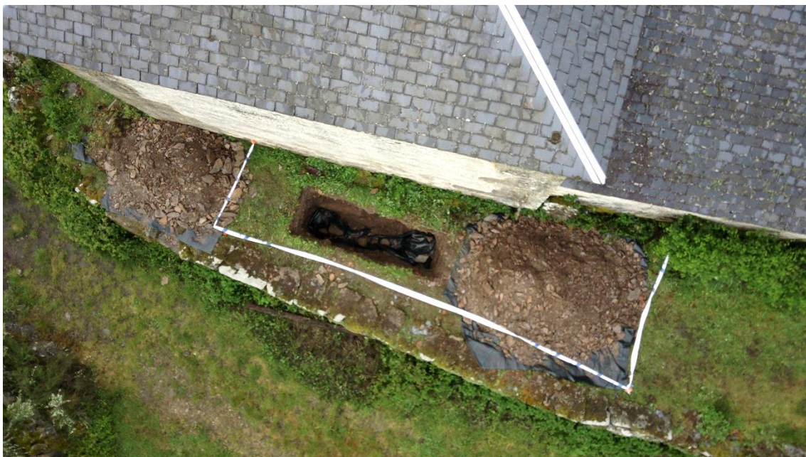
Tapado con xeotéxtil da sondaxe 2 e posición desde fotografía en altura.
