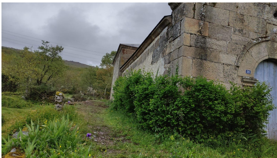
Estado final da área de intervención.
