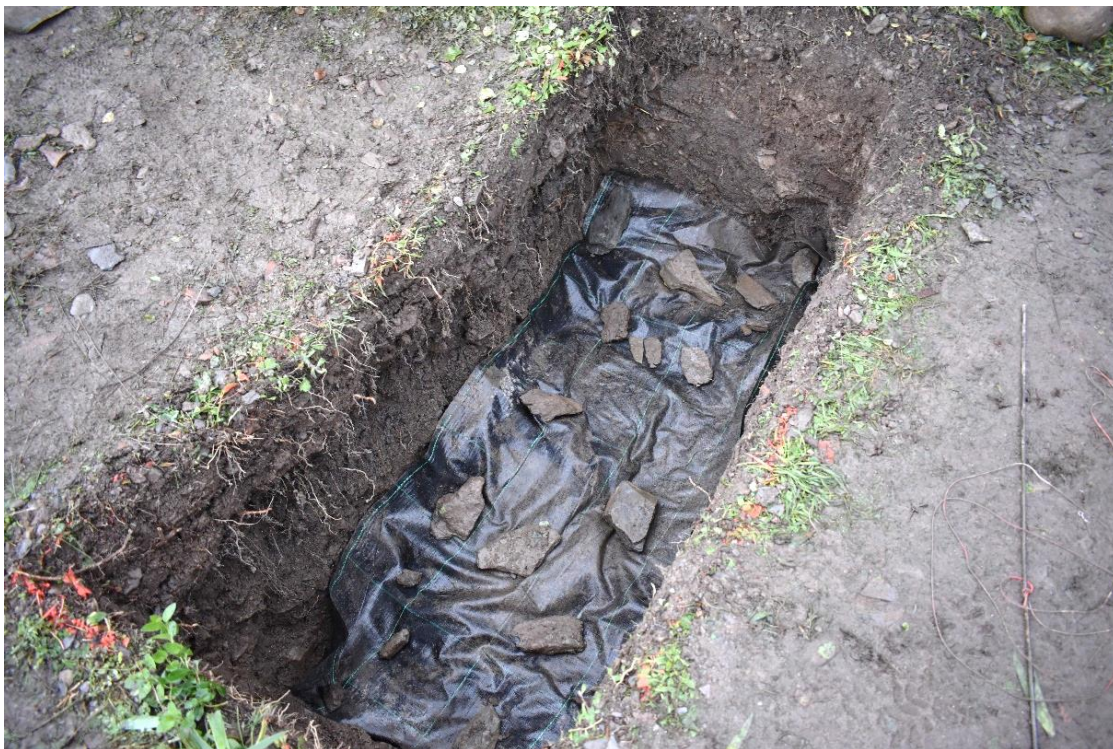
Proceso de tapado con xeotéxtil.
