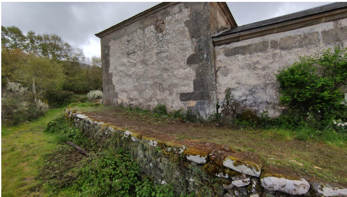
Estado final da área de intervención.
